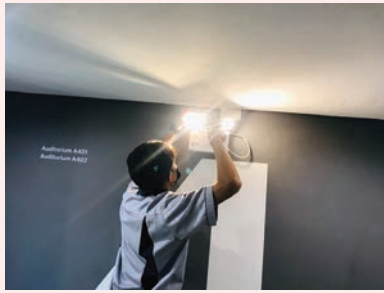
การตรวจสอบอุปกรณ์ ด้านความปลอดภัย ประจำเดือน
