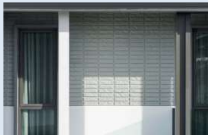
สีกันความร้อนและกระจกเขียวตัดแสง (UV Shield Colour and Heat-Absorbing Green Glass)
