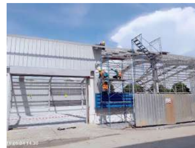
การควบคุมงานที่มีความเสี่ยง อาทิ งานบนที่สูง
